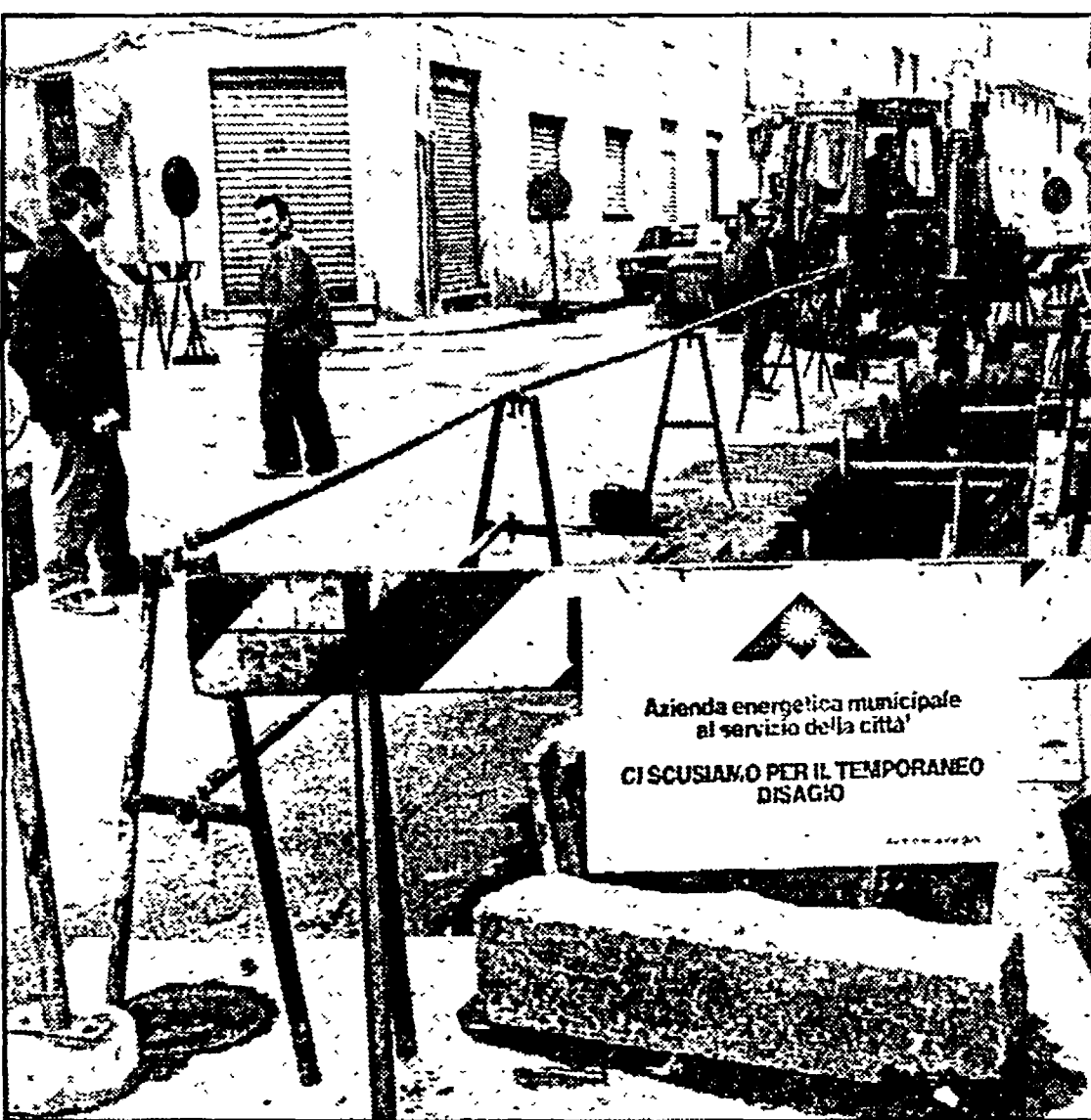
Un cantiere Aem per la posa dei condotti di metano a Milano
