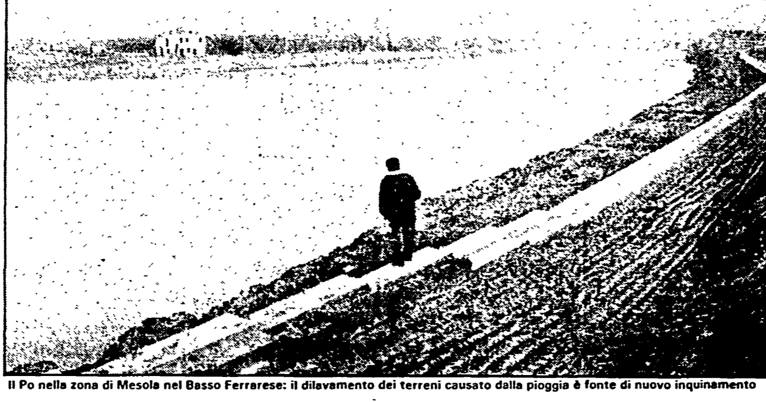
Il Po nella zona di Mesola nel Basso Ferrarese: il dilavamento dei terreni causato dalla pioggia è fonte di nuovo inquinamento
