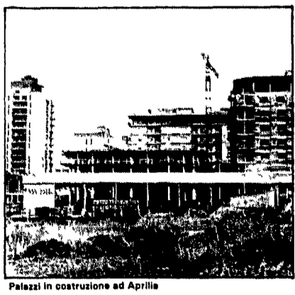
Palazzi in costruzione ad Aprilia
