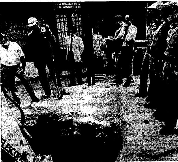
Ancora scavi nel cortile della villetta misteriosa di Acilia
