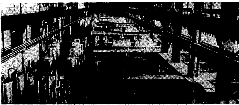
Una delle centrali termoelettriche di Civitavecchia
