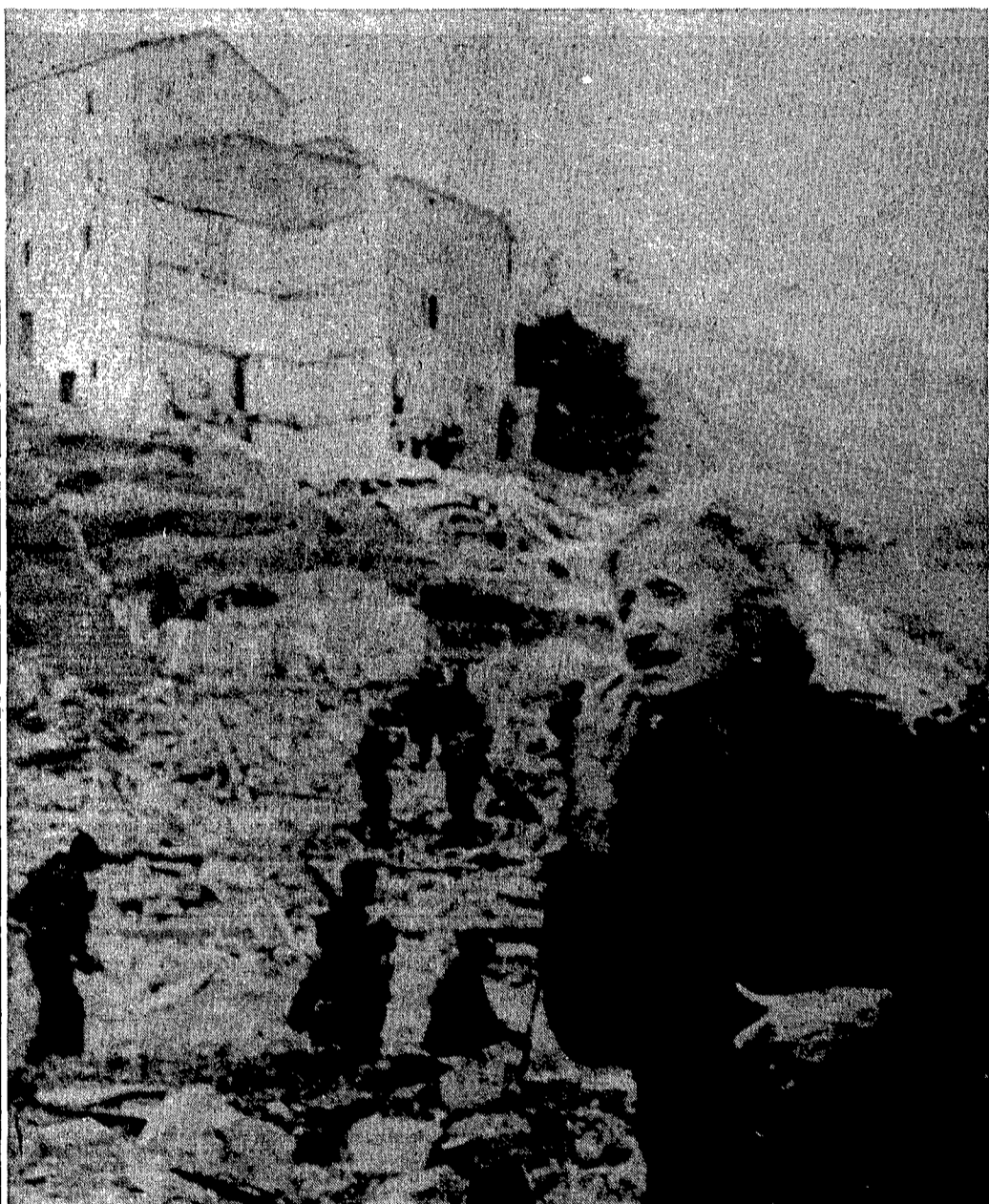
Ed ecco, nell'ottobre del 1963, la tragedia del Vajont, nel Bellunese. Un disastro immane che costerà la vita ad oltre duemila persone. Anche in questo caso, insipienza, faciloneria e gli scarsi controlli geologici, porteranno al dramma. In piena notte una grande frana scende giù dal monte Toc e precipita nell'invaso della diga del Vajont di proprietà di una società privata: la Sade. La massa enorme di terra, provoca la fuoriuscita
