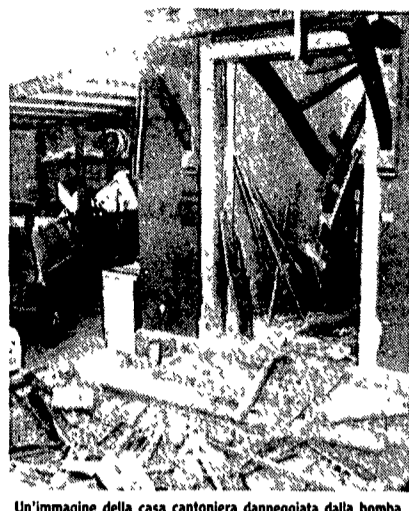
Un'immagine della casa cantoniera danneggiata dalla bomba
