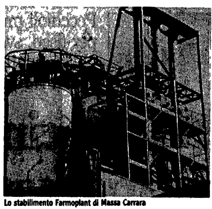
Lo stabilimento Farmoplant di Massa Carrara
