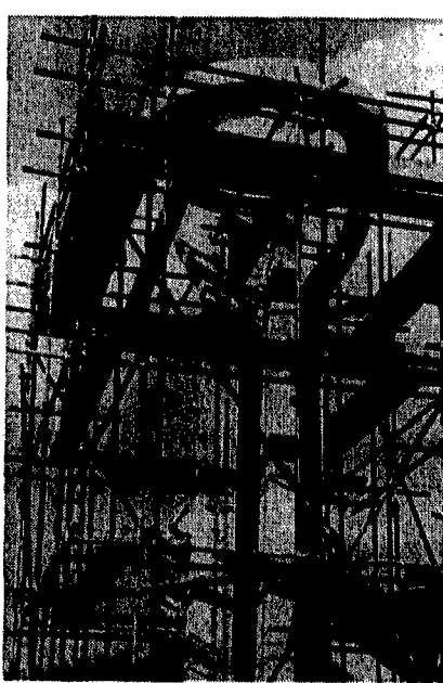
Al lavoro nel cantiere della Moschea di Forte Antenne e in alto il progetto del centro islamico
