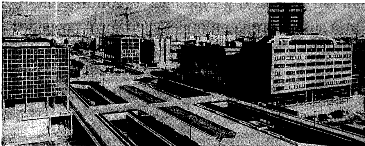
Alcuni edifici in fase di realizzazione del centro direzionale
