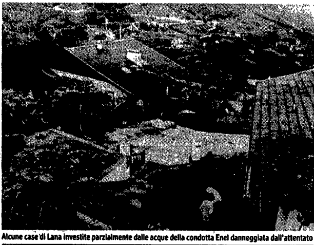
Alcune case di Lana investite parzialmente dalle acque della condotta Enel danneggiata dall'attentato
