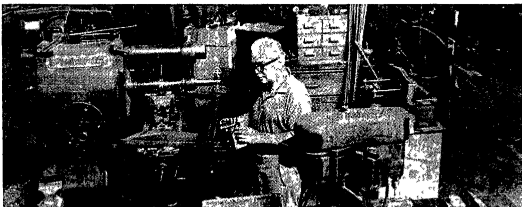
A fianco: una vecchia officina meccanica sotto, un carburatorista al lavoro, e sotto ancora un «moderno» parrucchiere per uomo
