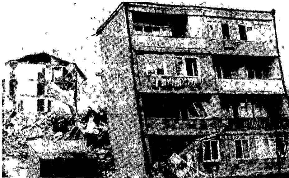
Un edificio della città di Spitak, nel nord dell'Armenia, letteralmente piegato dalla forza distruttiva del sisma. In alto a destra, Gorbaciov e Raissa mentre partono da New York. La cartina riassume i più gravi terremoti verificatisi in questo secolo.
