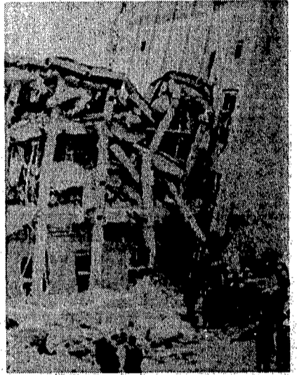
Un palazzo inclinato dalla furia del sisma
