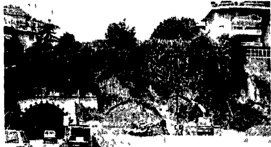
I lavori al raddoppio alla collina Fleming
