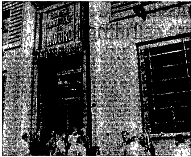
L'ingresso della direzione generale della Banca nazionale del lavoro a Roma
