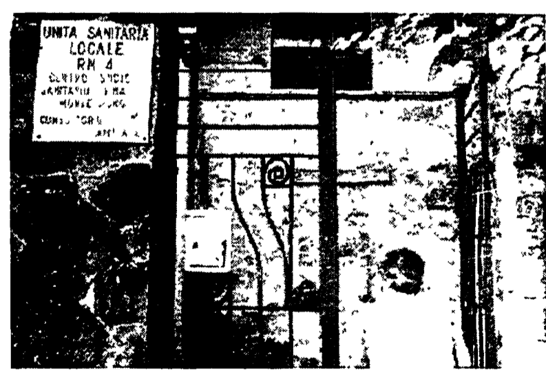
Scantinati e locali in disuso uniche sedi per i pochi consultori familiari in funzione
