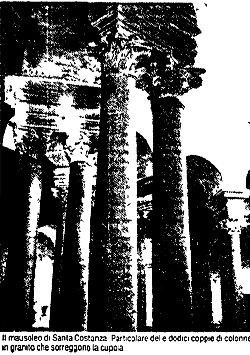
Il mausoleo di Santa Costanza. Particolare del dodici coppie di colonne in granito che sorreggono la cupola
