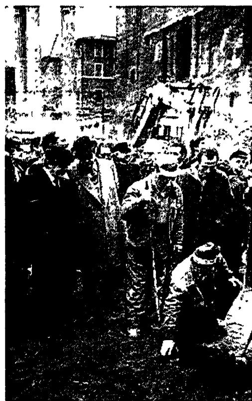
Dicembre 1980. Petroselli assiste all'inizio dei lavori in via della Consolazione. In alto, prospettiva del progetto di Raffaele Panella.
