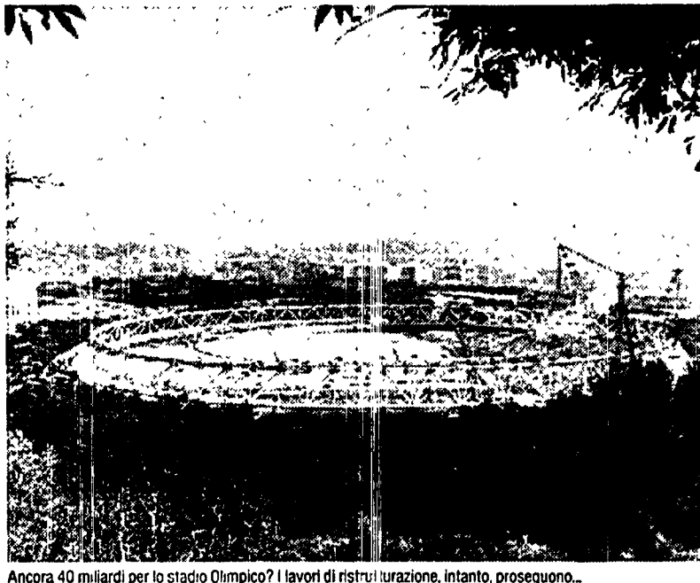
Ancora 40 miliardi per lo stadio Olimpico? I lavori di ristrutturazione, intanto, proseguono...
