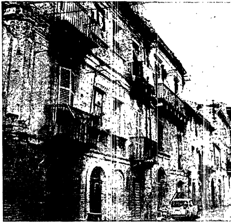
Un'immagine di degrado nel centro storico di Pescara
