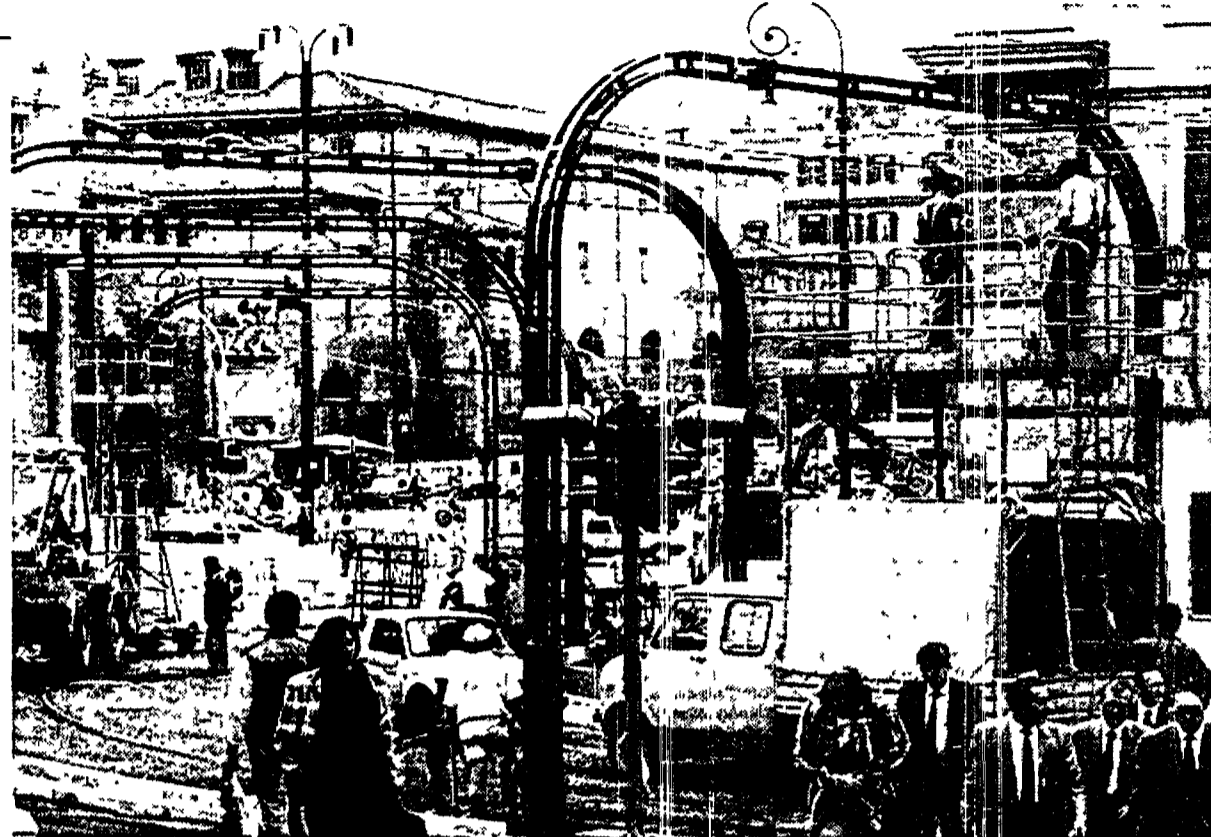
Il cantiere del tram veloce che collegherà piazzale Flaminio con piazza Mancini, ad alcune centinaia di metri dallo stadio Olimpico. Nella foto piccola la stazione dell'anello ferroviario di Farneto. I lavori sono ancora in alto mare (foto di Alberto Pais)
