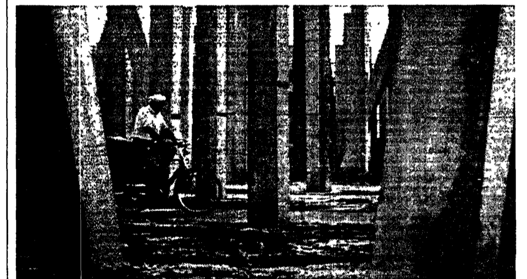
Un ciclista sembra essersi perso in un labirinto. In realtà sta attraversando i piloni di un ponte in costruzione nella città di Alblasserdam, una città a 15 km da Rotterdam.
