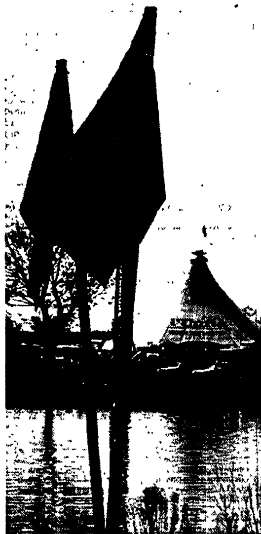
Una veduta della tonda dell'Unità
