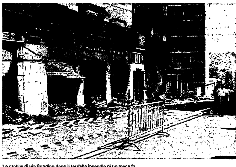
Lo stabile di via Gandino dopo il terribile incendio di un mese fa
