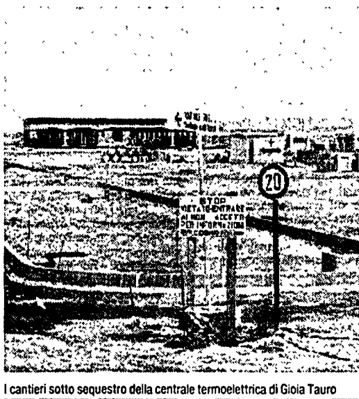
I cantieri sotto sequestro della centrale termoelettrica di Gioia Tauro
