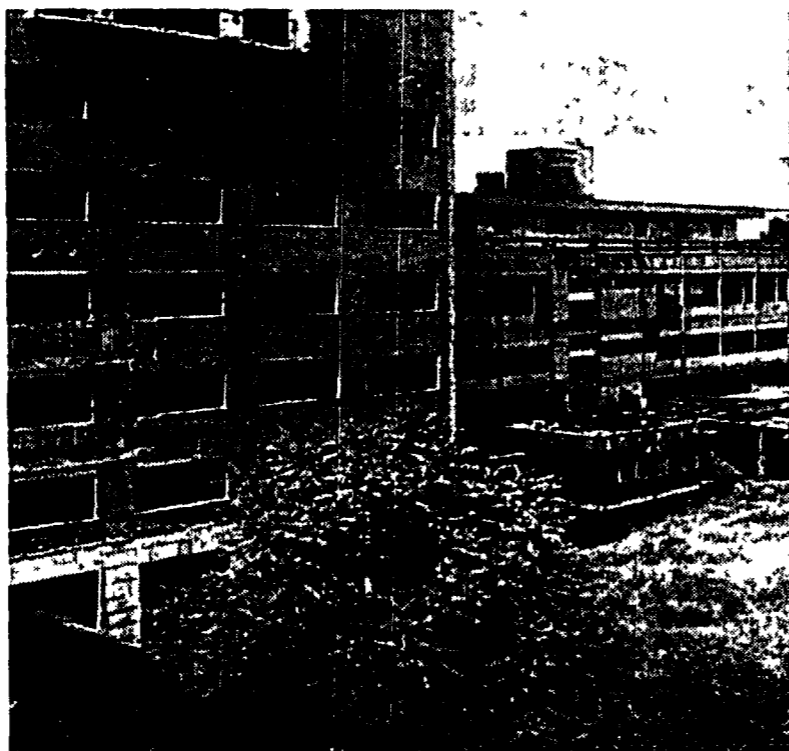
Una veduta dell'edificio dell'ex Pantanello
