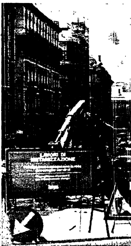
Lavori dell'Italgas per la metanizzazione in centro storico
