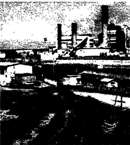
La centrale Enel di Fiumaretta
