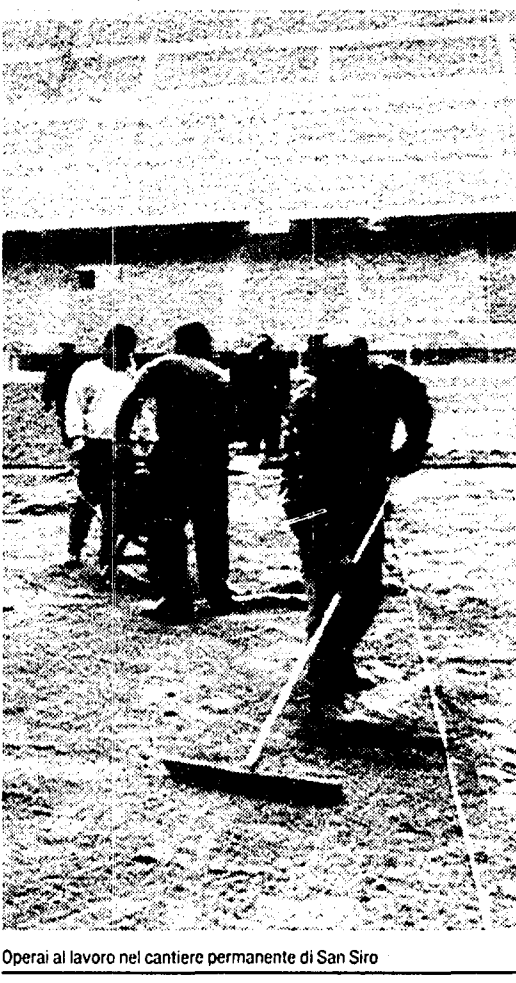
Operai al lavoro nel cantiere permanente di San Siro
