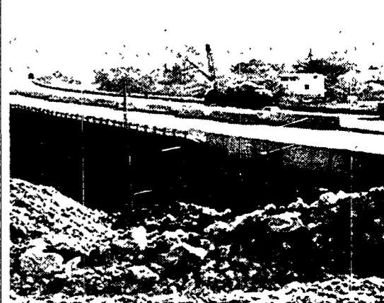
Un cantiere stradale
