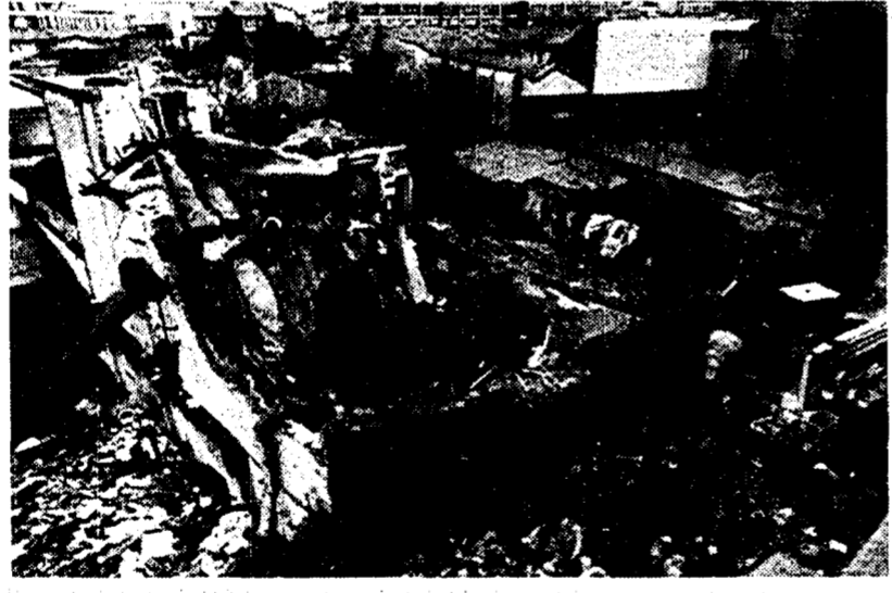
Una veduta aerea dello stabile saltato in aria alla periferia di Milano per una fuga di gas
