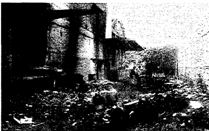
Il posto all'Ostiense dove si è verificato l'incendio
