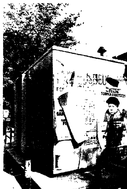
Una delle centraline di monitoraggio dello smog
