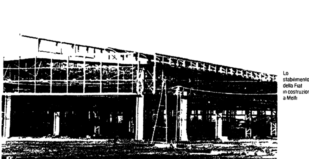
Lo stabilimento della Fiat in costruzione a Melfi
