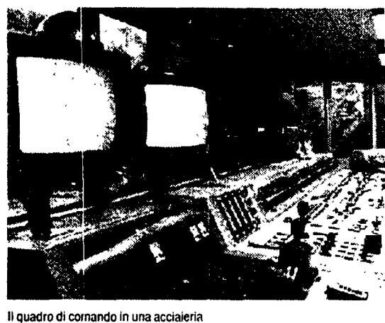
Il quadro di comando in una acciaieria
