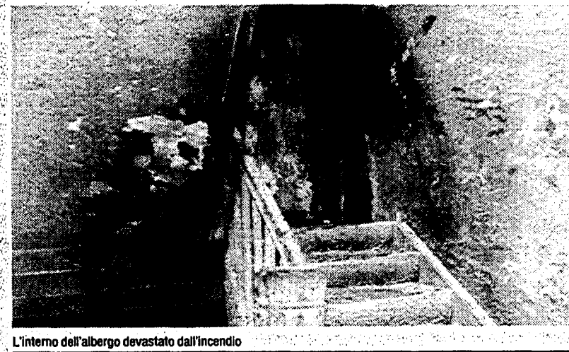
L'interno dell'albergo devastato dall'incendio
