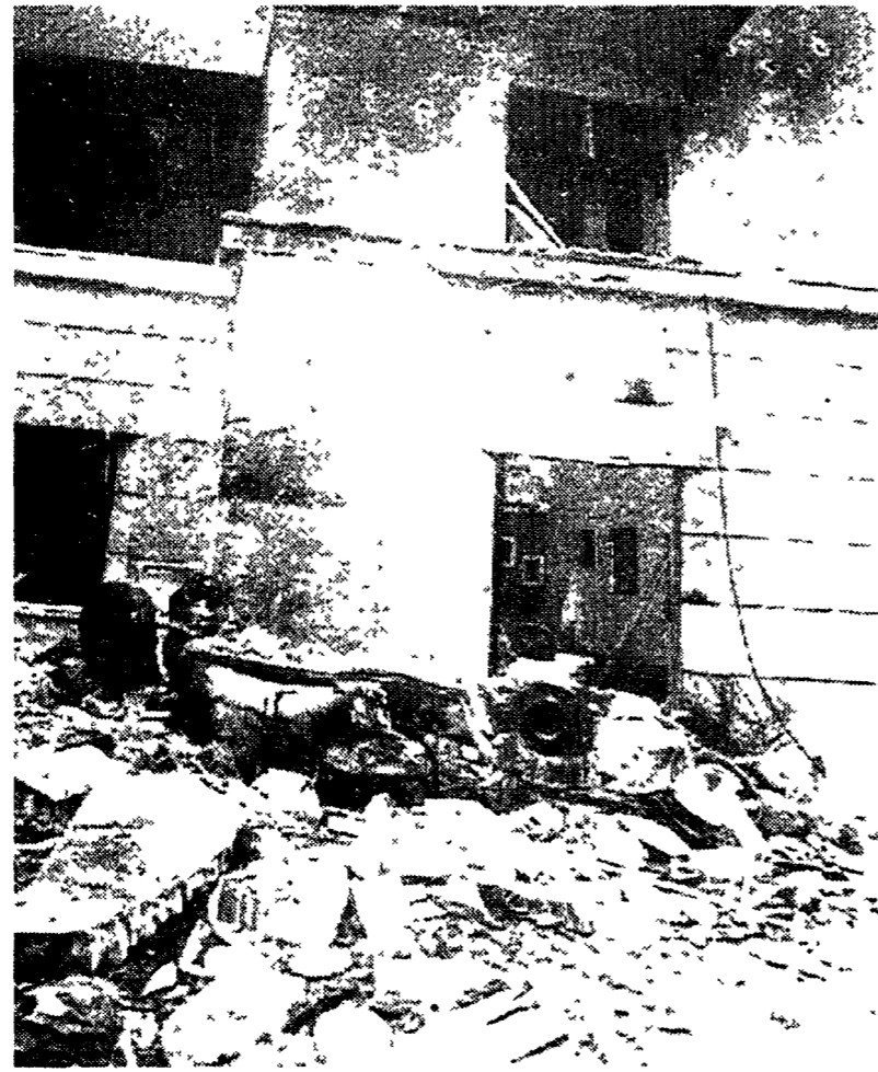
Un palazzo distrutto e altri gravemente danneggiati. Gli sfollati, i curiosi. La paura d'una brutta notte
