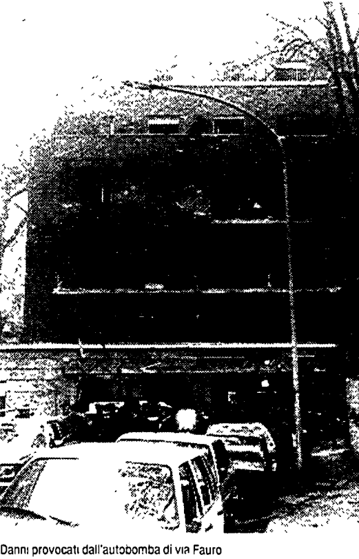
Danni provocati dall'autobomba di via Fauro
