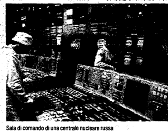
Sala di comando di una centrale nucleare russa
