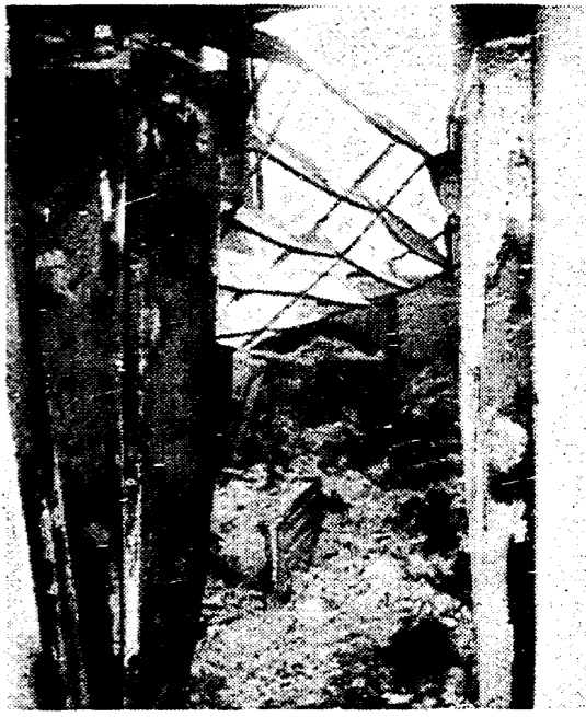
Un ufficio dell'Enichem di Crotona devastato dalle fiamme e, sotto, l'ingresso principale dello stabilimento dopo una notte di disordini
