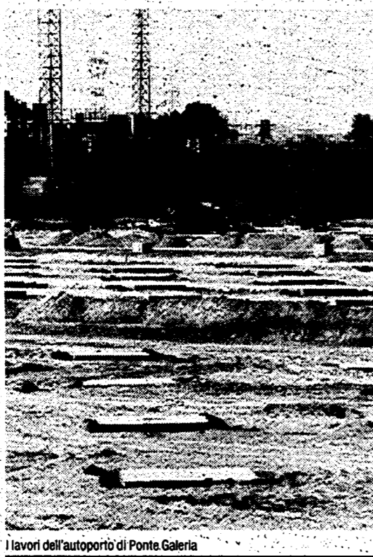
I lavori dell'autoparco di Ponte Galeria
