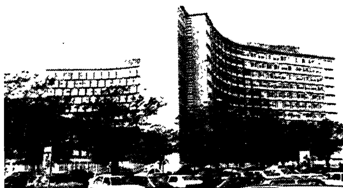
Il palazzo della Regione. A sinistra i passanti lavori per il prolungamento della metro B
