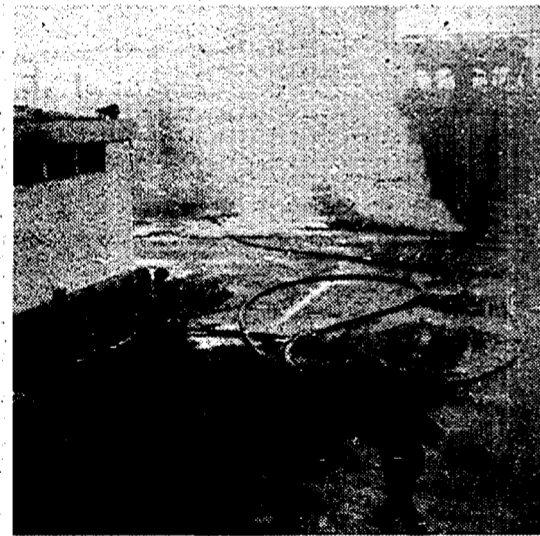
Un'immagine dell'incendio alla centrale Enel di Roma
