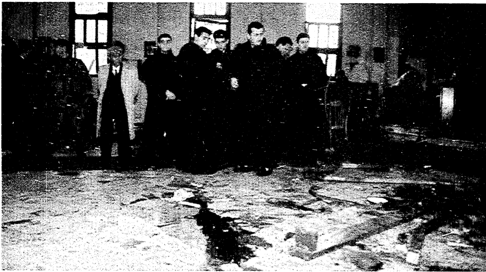
L'interno della chiesa cristiano maronita dopo la strage
