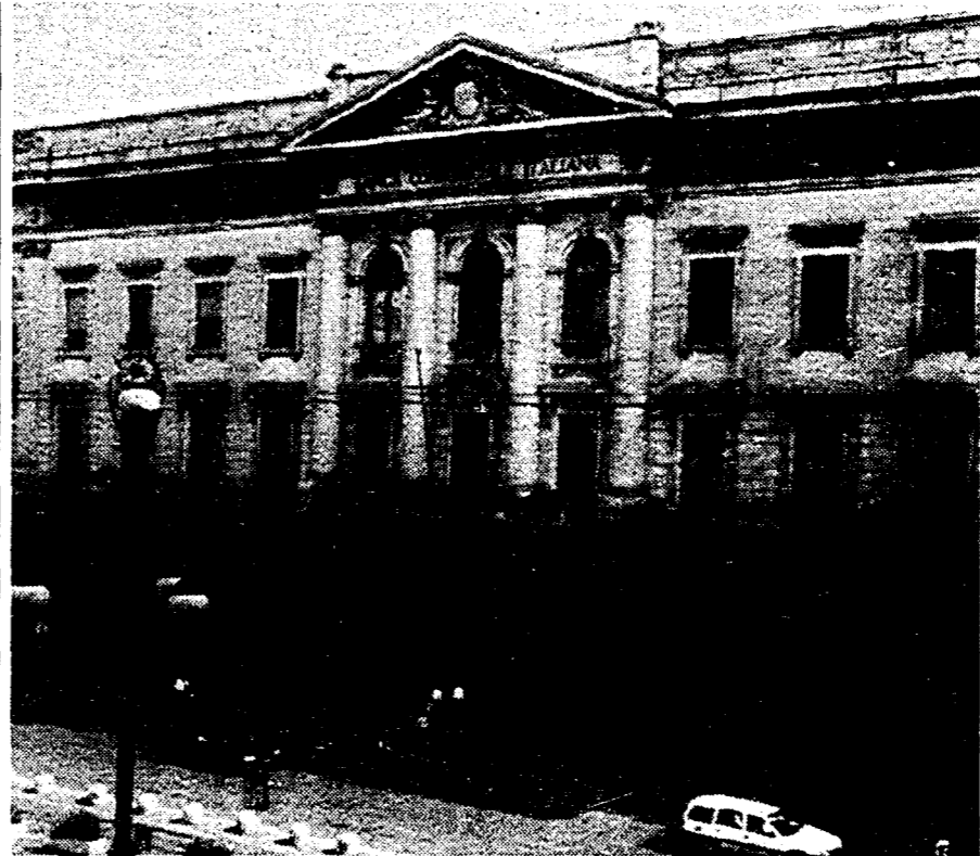
La sede centrale della Banca commerciale Italiana a Milano
