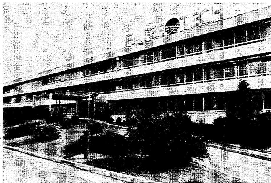
La sede di Modena della Fiat-Geotech/New Holland
