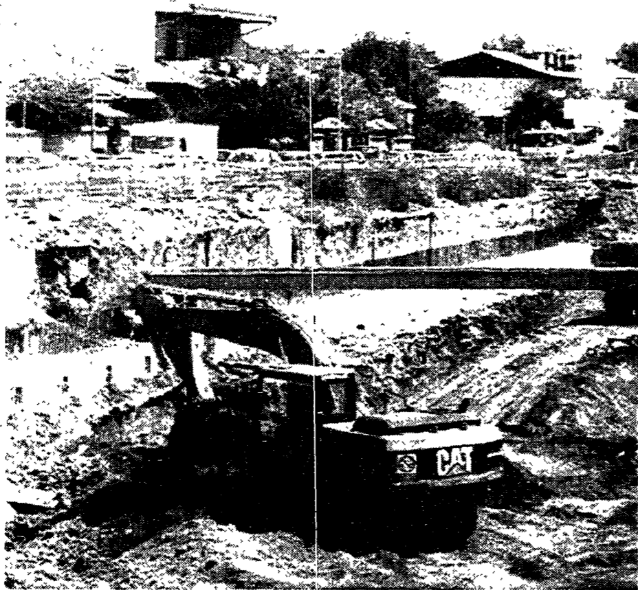
Ingresso ad Acilia per la costruzione del tunnel a sei corsie
