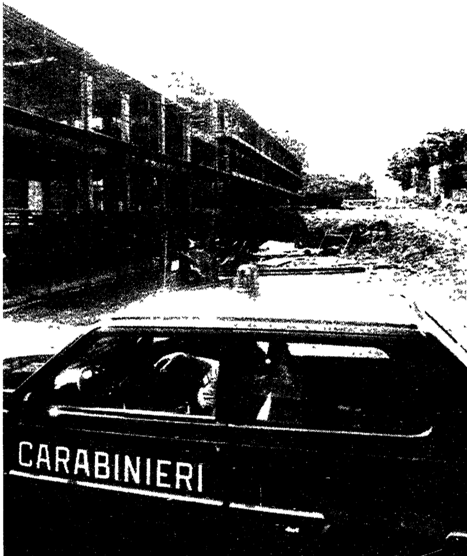
Il cantiere a Lunghezza; nella foto a sinistra dove è stata rinvenuta la bomba
