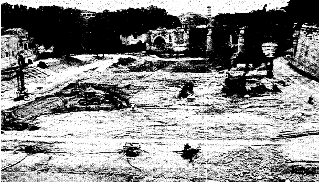
Lavori nell'alveo del fiume Tevere all'Isola Tiberina
