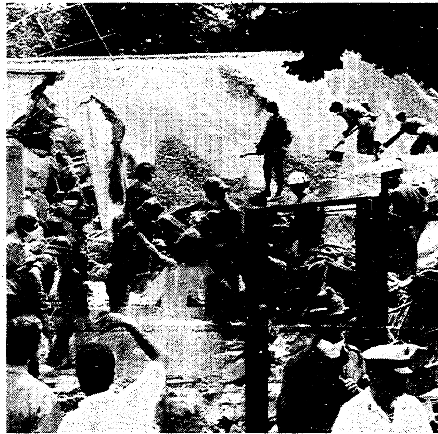
Si scava tra le macerie della casa di riposo crollata per un'esplosione
